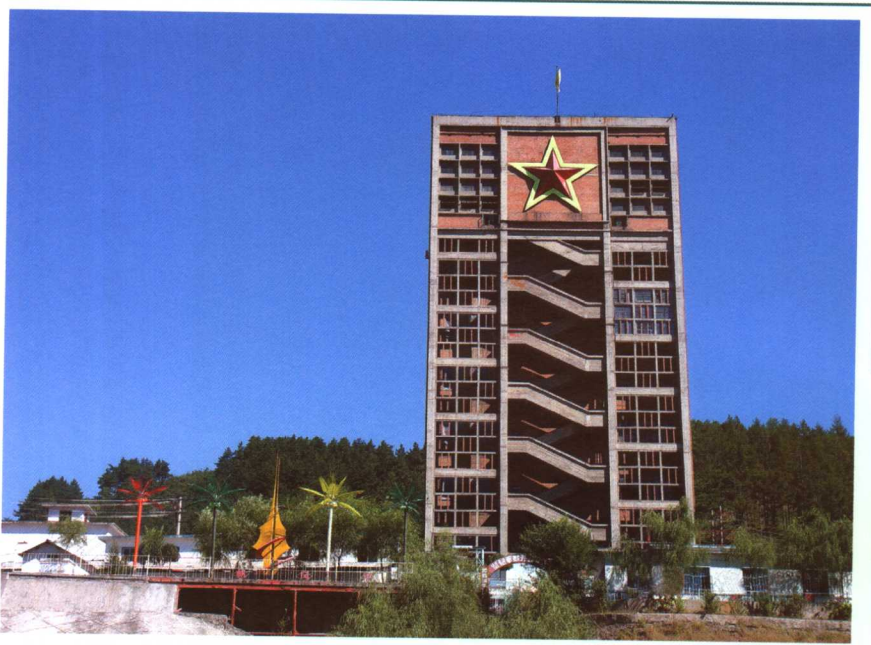
红透山坑口井塔
