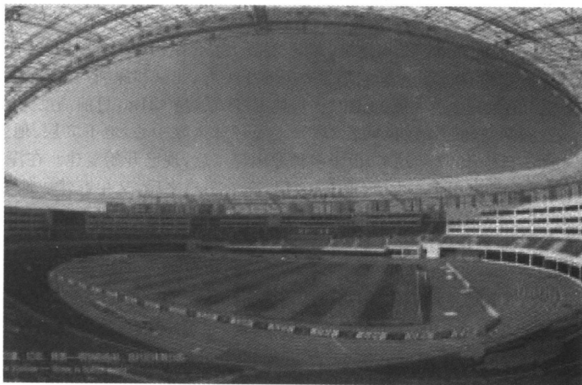
图 1.5 某体育场钢屋盖
