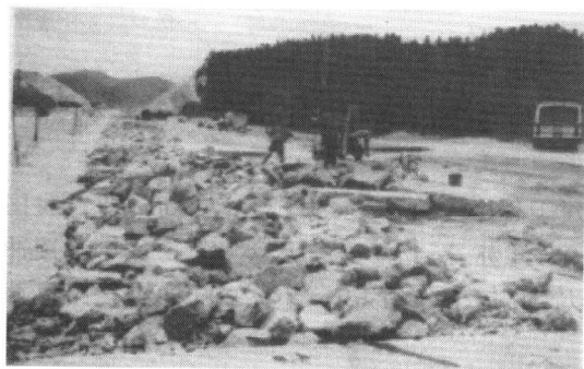
图 1.1 传统的水泥路面破碎修复方法
