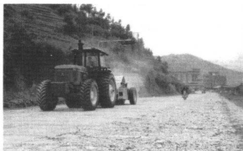
图 1.4 福建三明 24 公分厚水泥混凝土路面破碎工程
