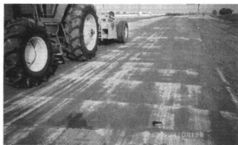
图 1.5 美国加州 99 号高速公路罩面前的打裂压稳 [38]
