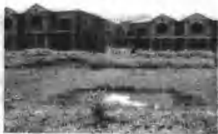
图1-1 浙江永康“烂尾楼”
