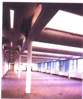
图 23-7 朝南的大开间办公室内每个天花单元内装设了 5 盏连续的悬吊灯具，同时走廊上沿垂直方向装设一只
