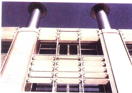
图 23-6 建筑的外部采用了透明玻璃格栅
