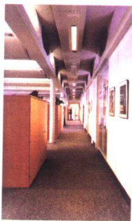
图 23-7 朝南的大开间办公室内每个天花单元内装设了 5 盏连续的悬吊灯具，同时走廊上沿垂直方向装设一只
