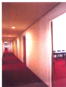
图 23-15 走廊上采用 PL/26W 的筒灯来提供照明
