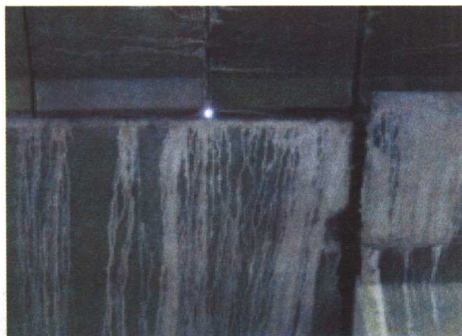
b) 预应力混凝土箱梁桥桥面系漏水，除冰盐
