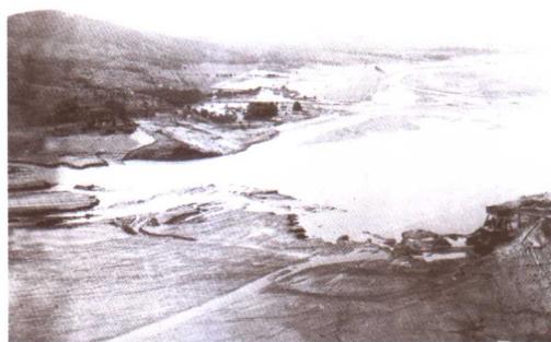
1975年溃坝失事后的石漫滩水库
