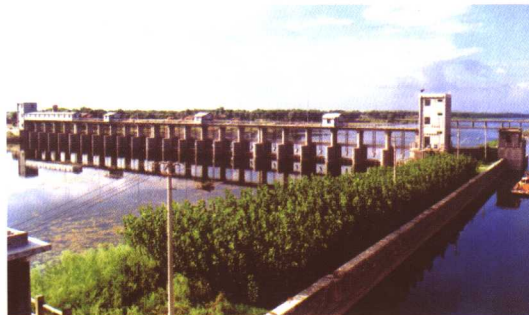
南四湖复新河节制闸
