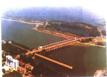
茨淮新河上桥枢纽
