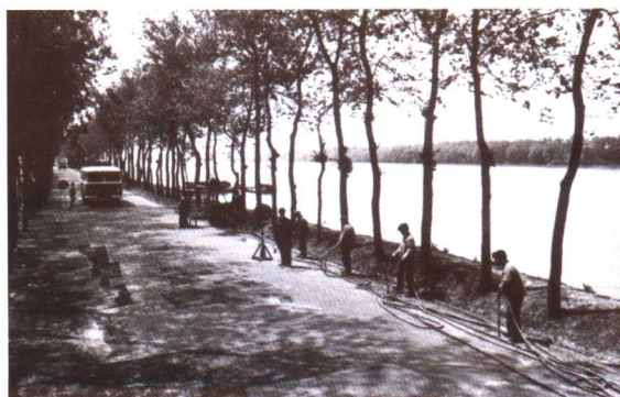
1983年京杭大运河江苏高邮段堤防加固
