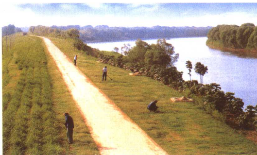
沙河“五化”堤防
