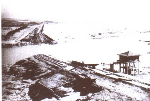
1975年溃坝失事后的板桥水库
