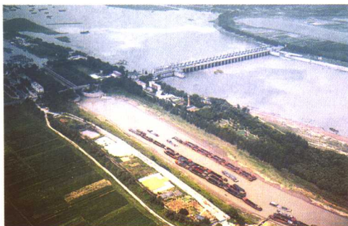
淮河蚌埠闸枢纽
