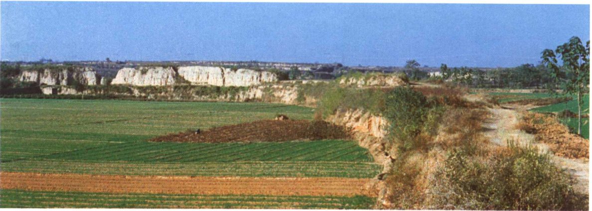
汉魏洛阳城墙垣东北角现状
