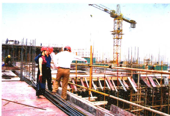
图5 图书馆领导和工程技术人员在施工现场
