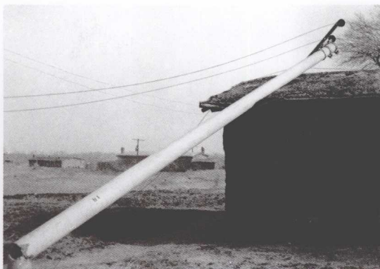
1983年4月29日，齐齐哈尔刮暴风，中华路一带，水泥电柱倾倒压在居民住房上
