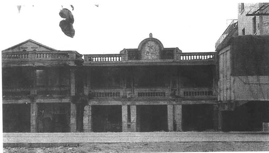
图11 泉安公路 安海车站
