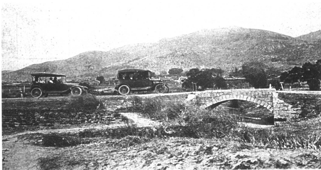
图8 泉安公路灵水第三直拱石桥
