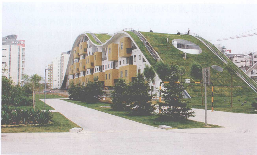
↑ 图 2-1 北京某小区屋面的生态处理
