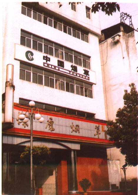
■ 1988年3月在县城潭头湾新建烟草专卖局（公司）办公大楼，建筑面积4190平方米
