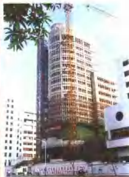
正在兴建中的营业大楼 (地址：江华二路)
