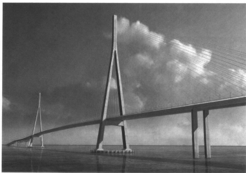
图5 世界上跨度最大的斜拉桥——苏通大桥(主跨 1088 m)
