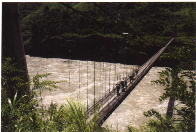
2001年重建的雅鲁藏布江 解放大桥 (庞涛 摄)
