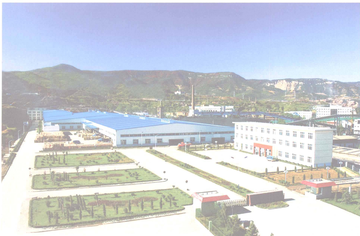
南庄矿煤研石砖厂全景
