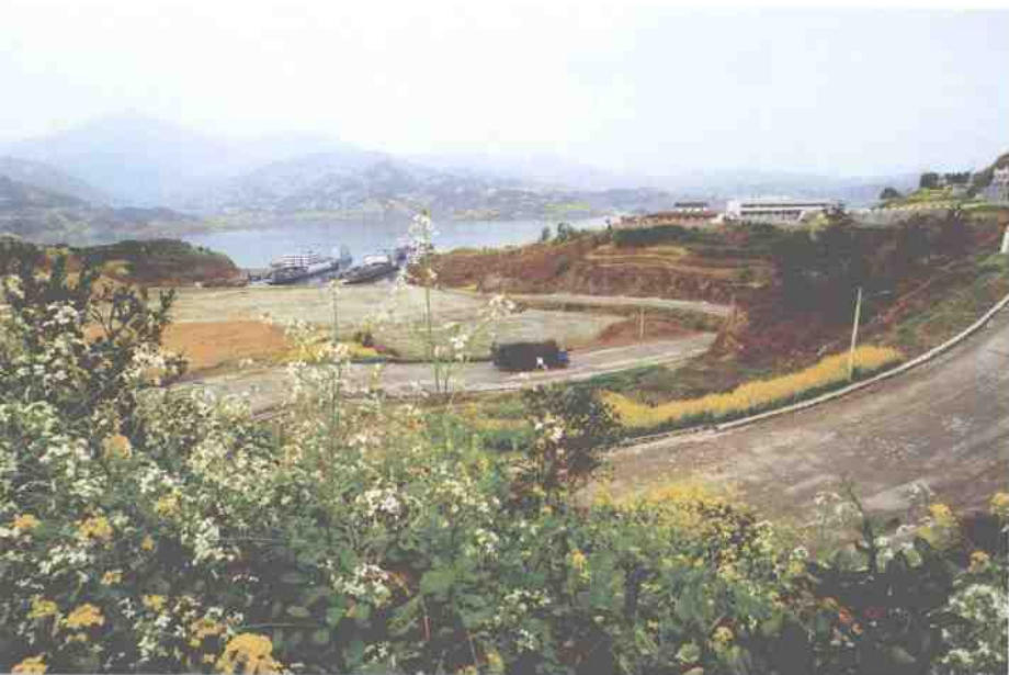
建设中的翻坝码头
