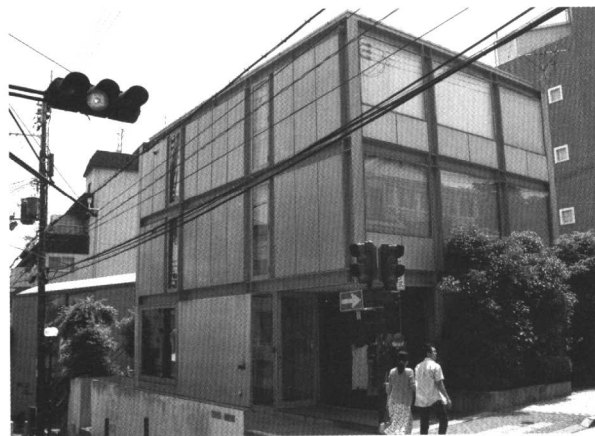
图1-14 WALL STEP的临街部分采用了钢结构
