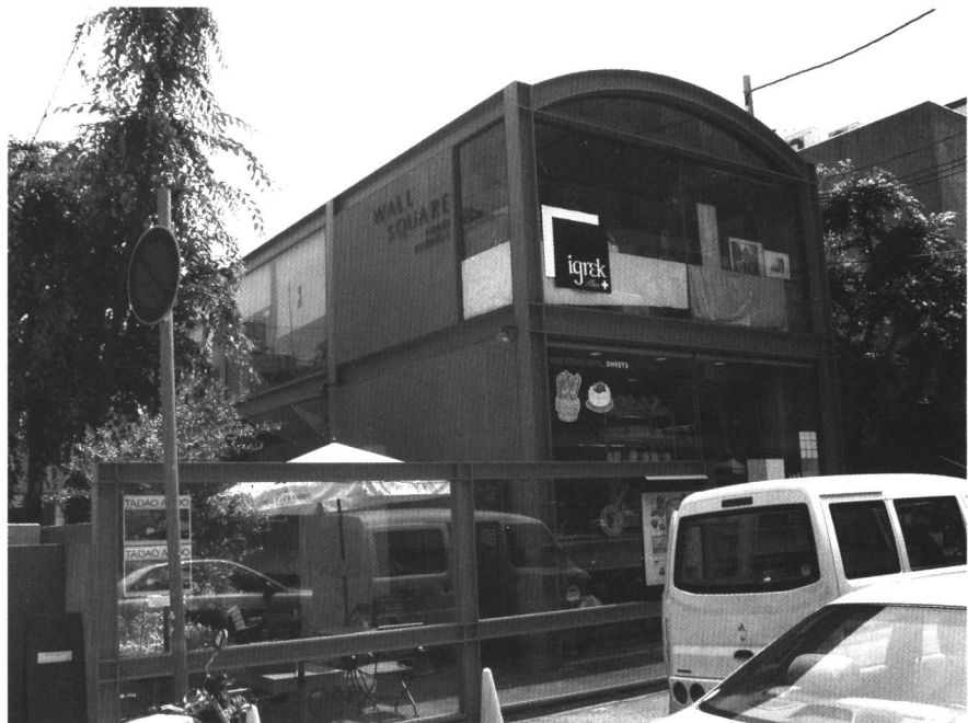
图1-17 WALL SQUARE用钢结构围出一片天地
