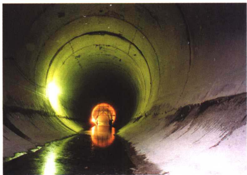
天生桥二级水电站引水隧洞
