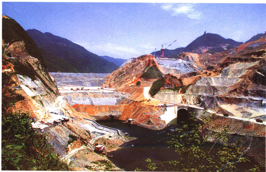
三板溪水电站施工现场
