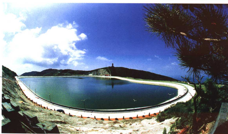
十三陵抽水蓄能电站上水库
