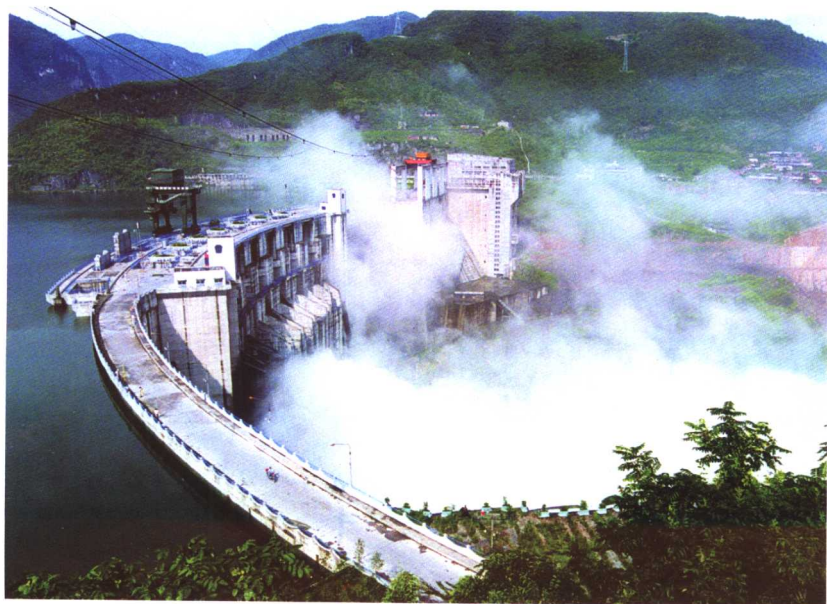
隔河岩水电站
