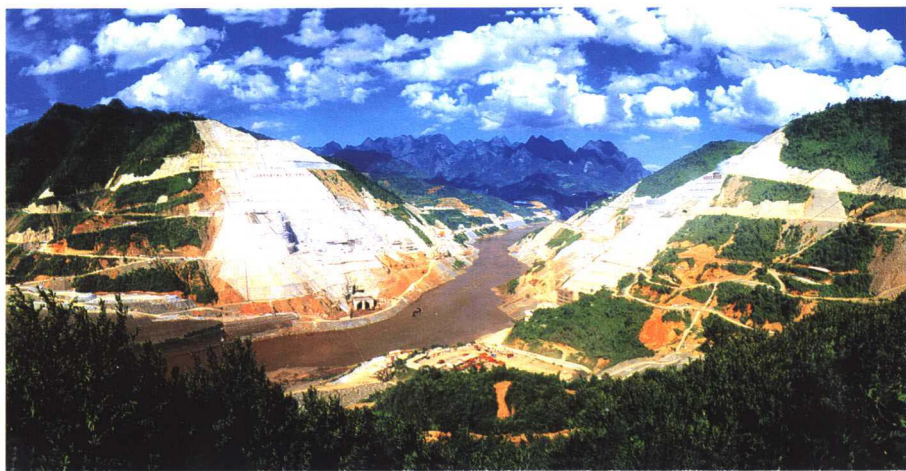
龙滩水电站两岸边坡施工
