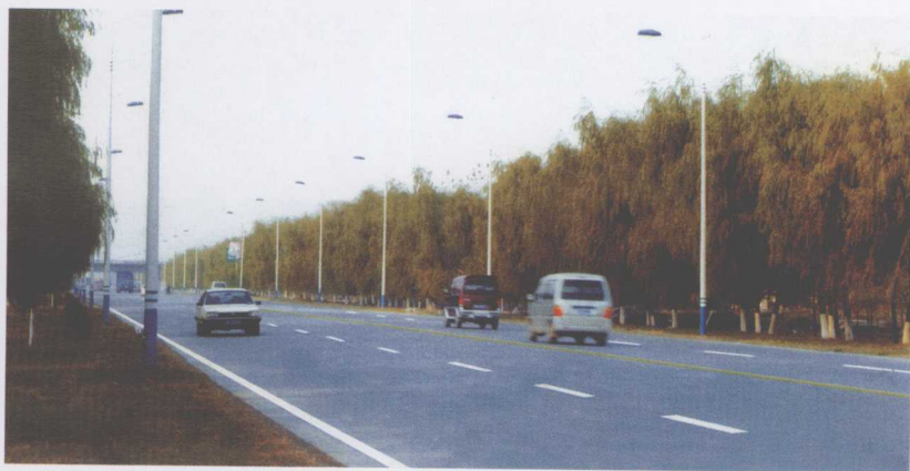
河东公路局主要担负着河东区三条国道、两条省道计123公里的公路建设、养护、管理等任务。近年来,累计投资2亿多元,完成了区内78.8公里干线公路改建、大修、绿化、美化工程。图为该局管护的206国道河东绕城线。
