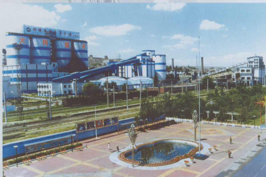
千万吨级矿井建设
