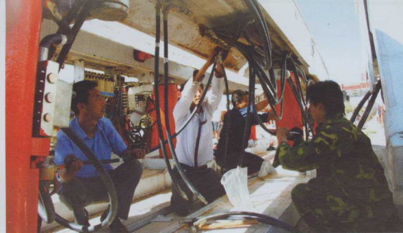
组装采煤设备
