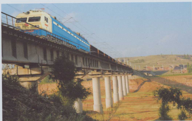
伊泰准东铁路
