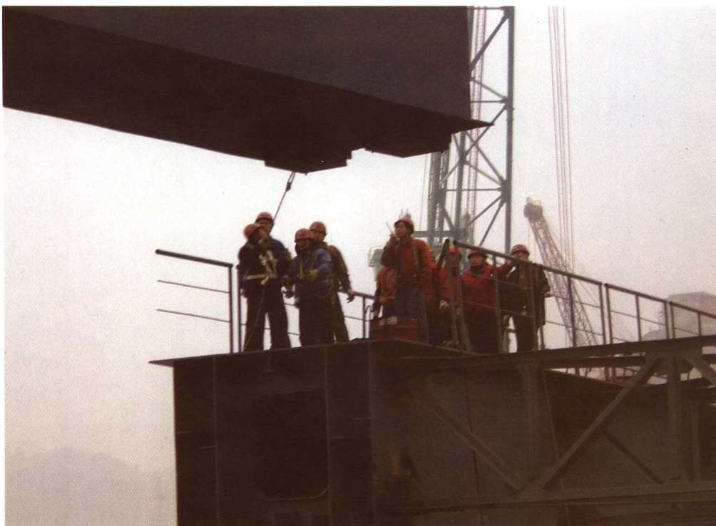
三峡工程 120 栈桥钢箱梁就位
