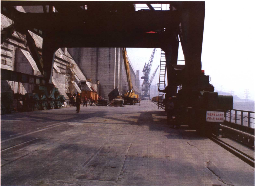
三峡工程 120 栈桥门机车道布置
