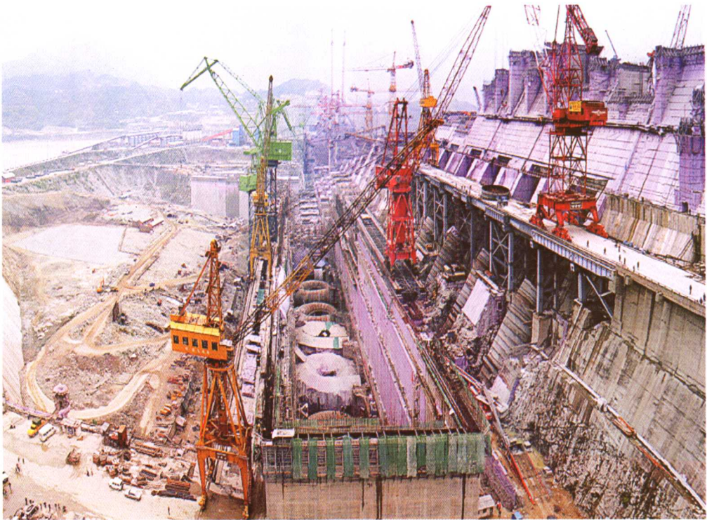
三峡工程 120 栈桥下部压力钢管安装
