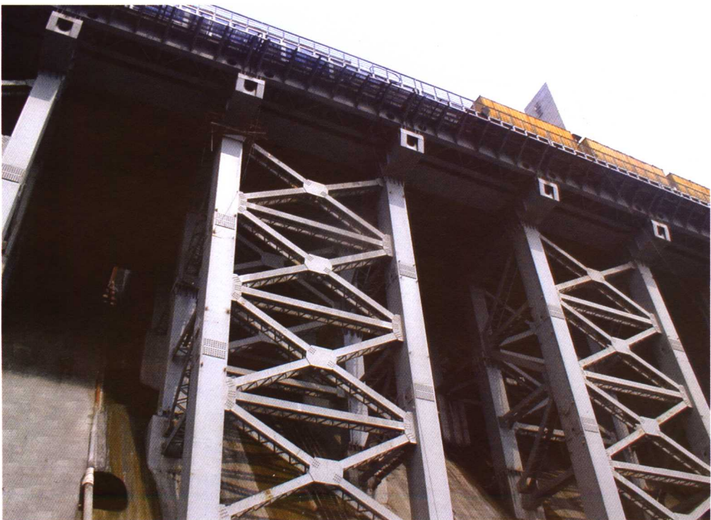
三峡工程 120 栈桥下部支撑结构
