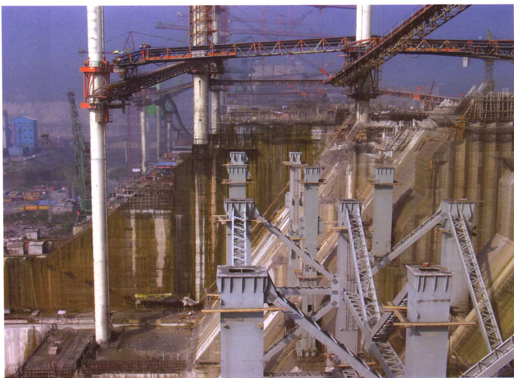
三峡工程 120 栈桥下部结构
