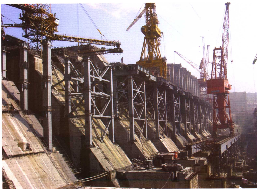
三峡工程 120 栈桥安装
