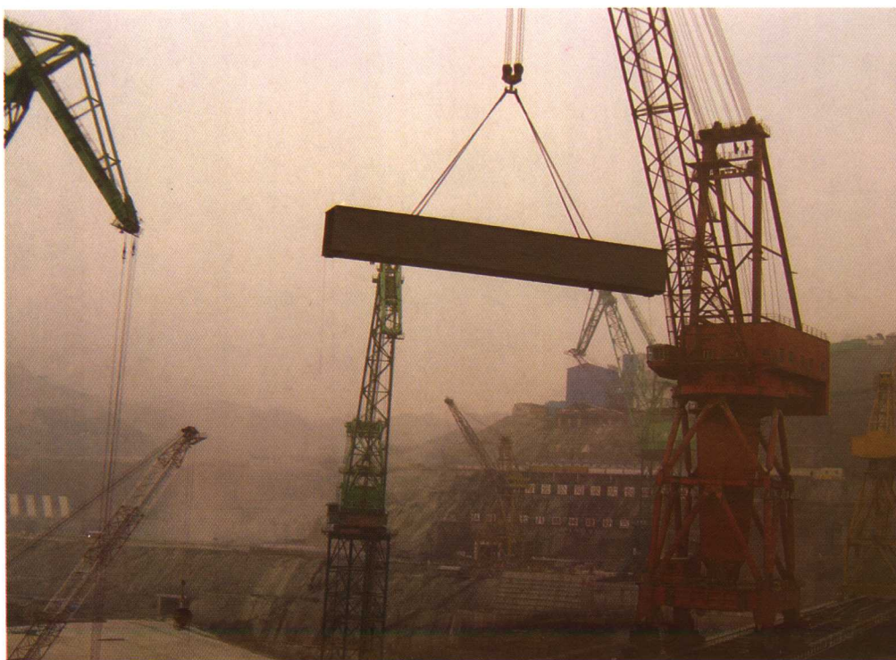
三峡工程 120 栈桥钢箱梁吊装
