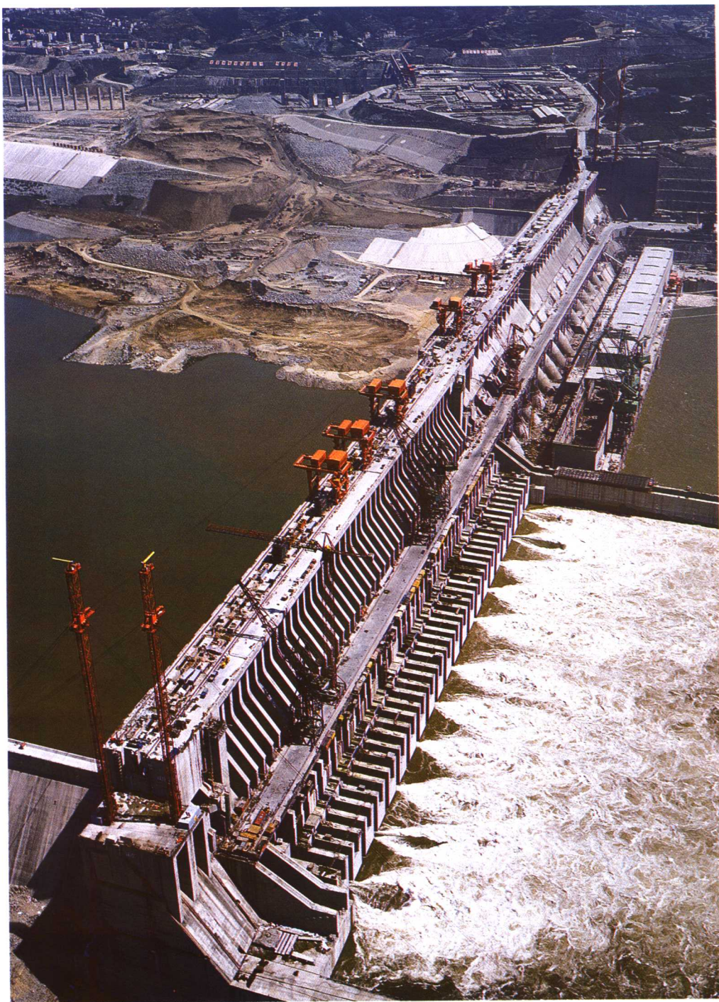
三峡二期工程 120 栈桥鸟瞰图
