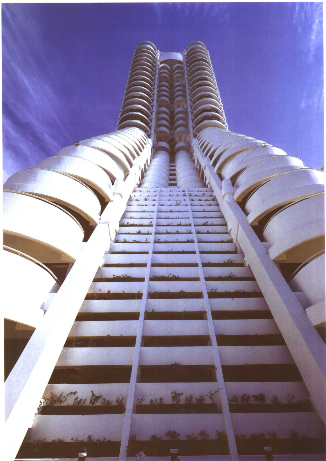
图 13 MBF 大厦实景
