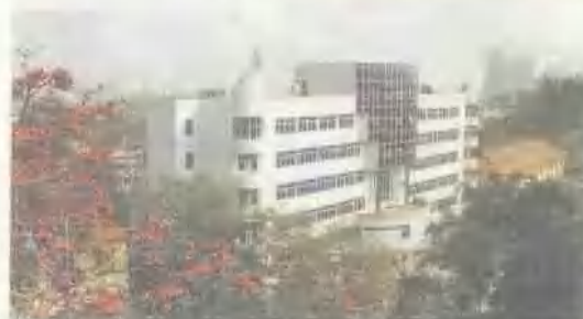
◀至2003年,广西有普通高中519所(含完中326所),在校生58.51万人。图为自治区级示范性高中——南宁市第三中学校园新貌
