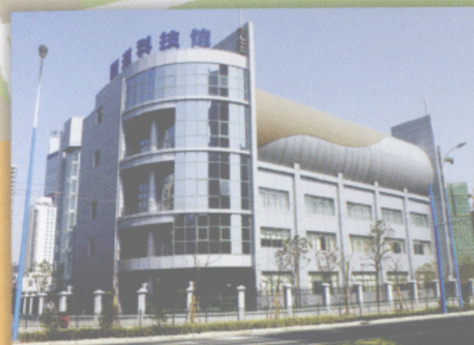
⑧上海隧道科技馆 p21
