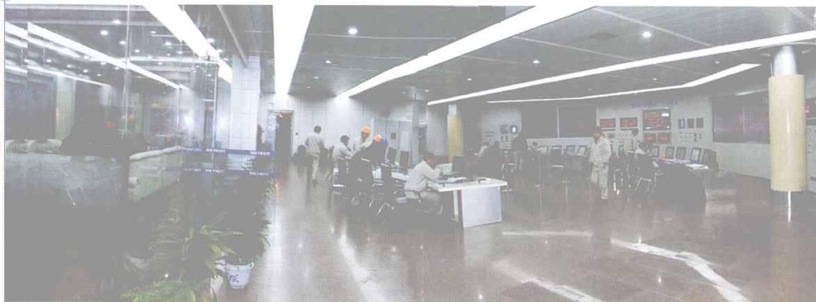
平圩发电有限公司集控室
