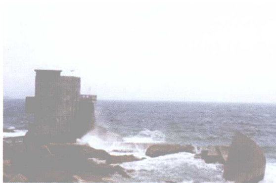
汕尾 100 千瓦波浪电站外观
