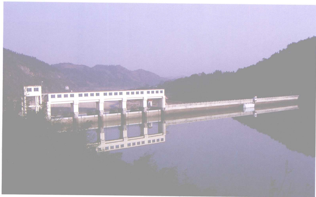
安徽响洪甸抽蓄电站下库
