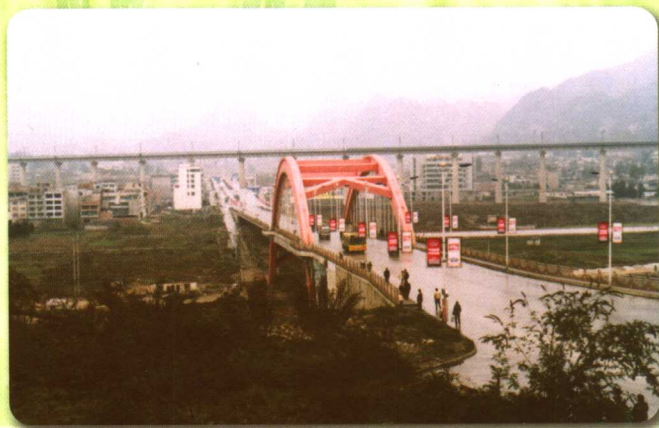
▲ 市财政投资4 760万元建设的市中心区白鹤高架桥
