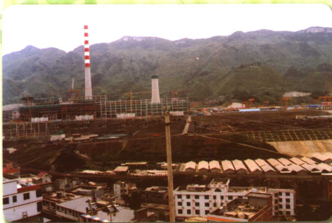
▲市财政和盘县财政支持电厂建设。图为在建中的盘南电厂
