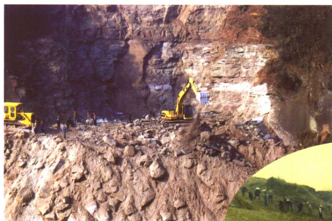
龙潭水库施工场景
