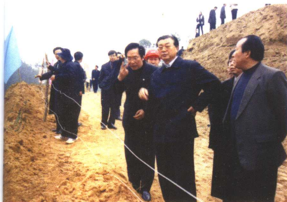
2001年，副省长邹广严（右二）视察龙潭水库建设工地
