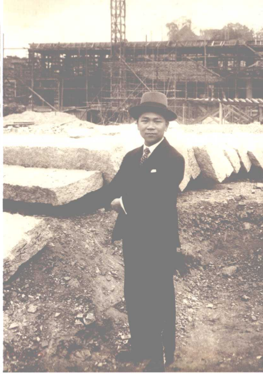
▲ 黄檀甫在广州中山纪念堂建筑工地上
