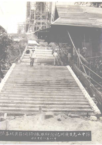
▶ 中山纪念碑石级路（今人所称“百步梯”）钢筋混凝土毛胚施工现场
