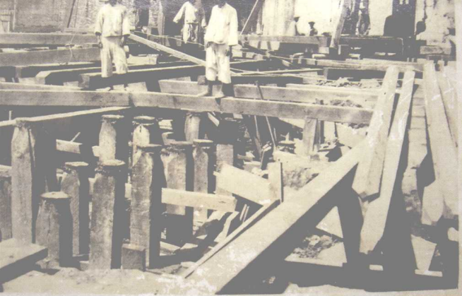
◀ 广州中山纪念堂打木桩地基现场
