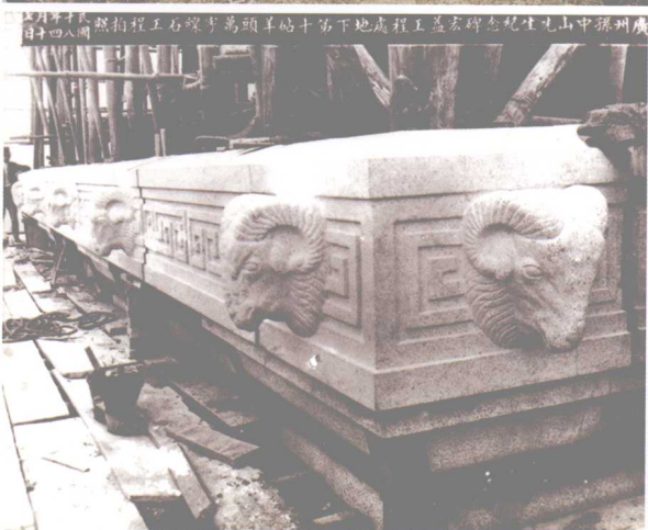
▶ 中山纪念碑二层平台外侧石羊头及万字线石雕刻工程施工现场
