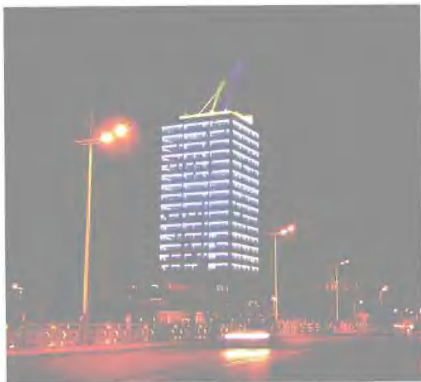
位于沂河之滨的临沂市工商局办公大楼
