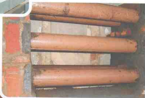
普改密烤房耐火材料列管式换热器 ▶
