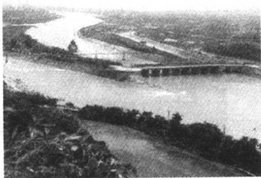
图 1.5 四川都江堰输水工程
