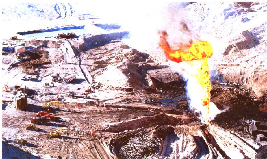
隆 5 井井喷着火现场
