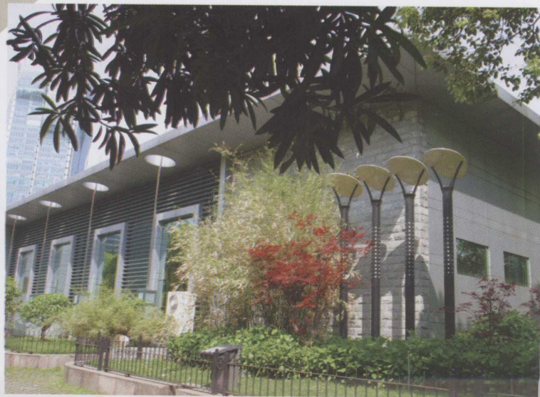
220kV地下变电站
