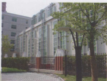
城区220kV变电站
