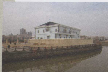
35kV户内变电站
