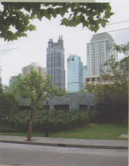
城区110kV变电站
