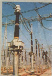
500kV电流互感器 220kV同塔双回线
