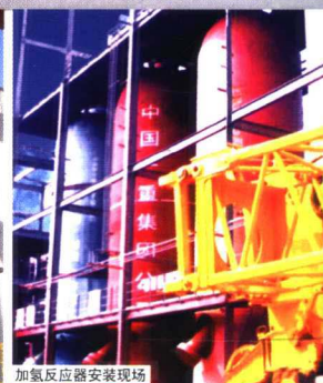
加氢反应器安装现场
