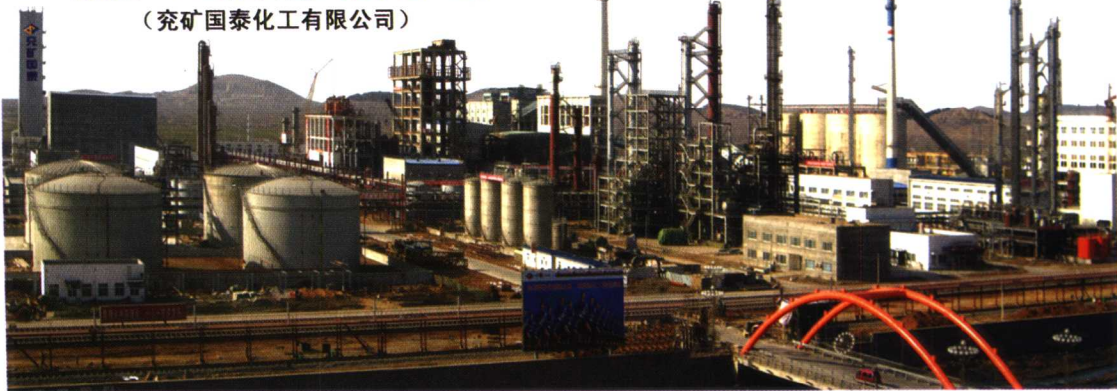
日处理 1150 吨煤水煤浆气化示范厂全景 （兖矿国泰化工有限公司）
