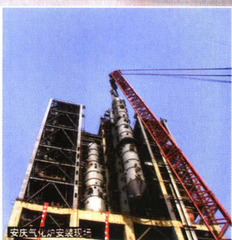
安庆气化炉安装现场
