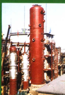
正在安装的加压变换炉
