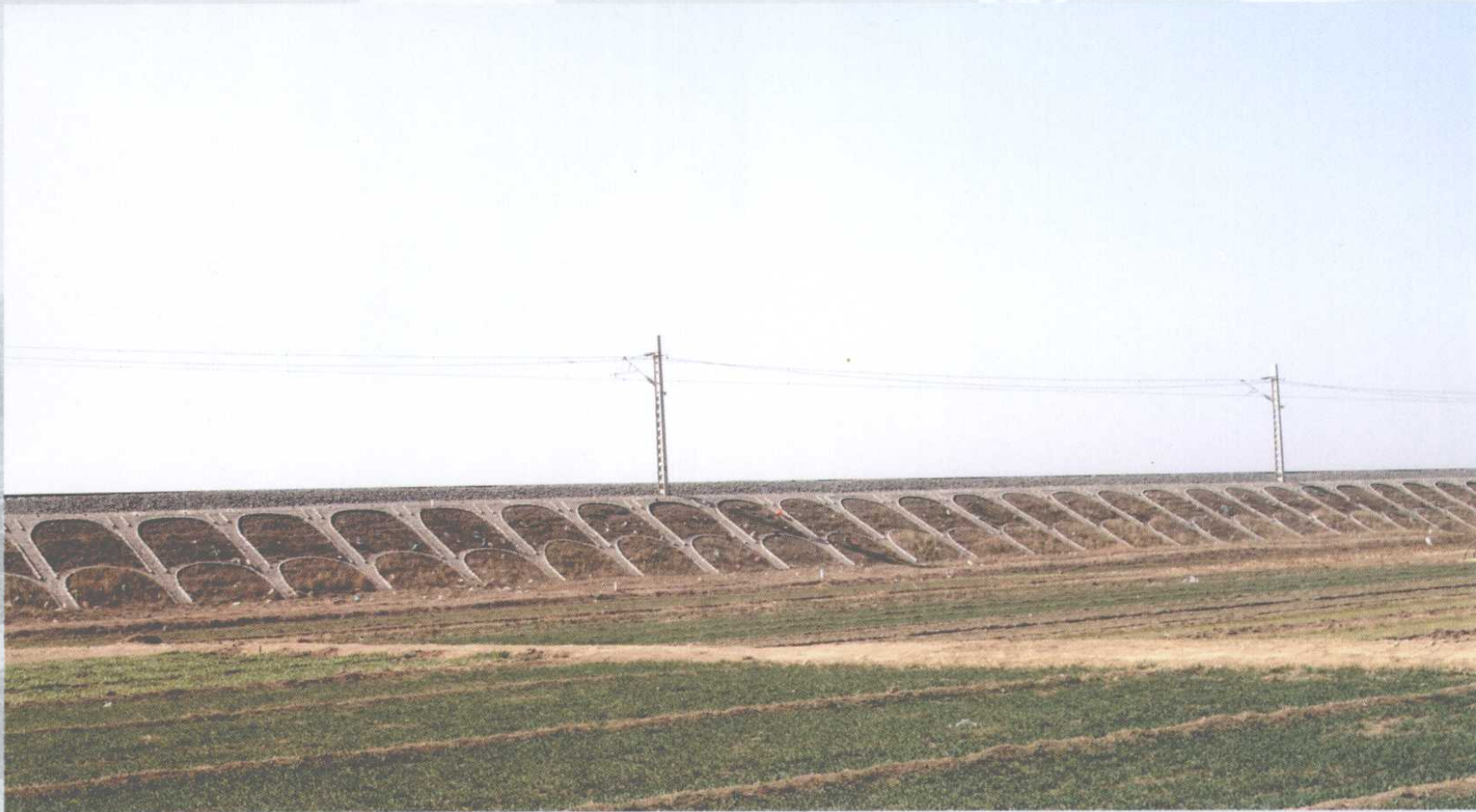
利用盐渍土修筑路基
