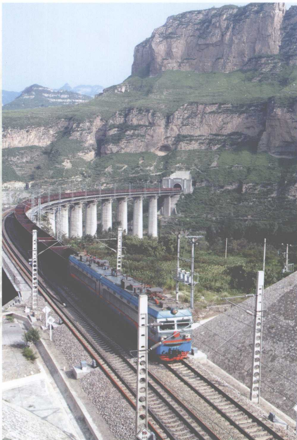
第四长大双线隧道寺铺尖隧道
