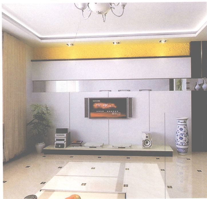
石膏板造型外涂白色乳胶漆
