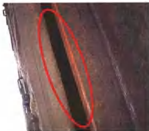
图 1-4 棚车车门一侧出槽
