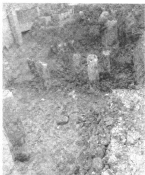
钻孔灌注桩开挖后
