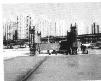
锚桩法抗压静载试验
