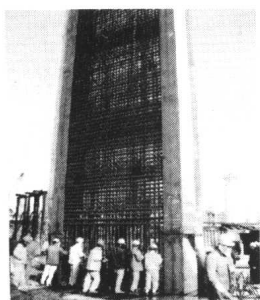
地下连续墙钢筋笼
