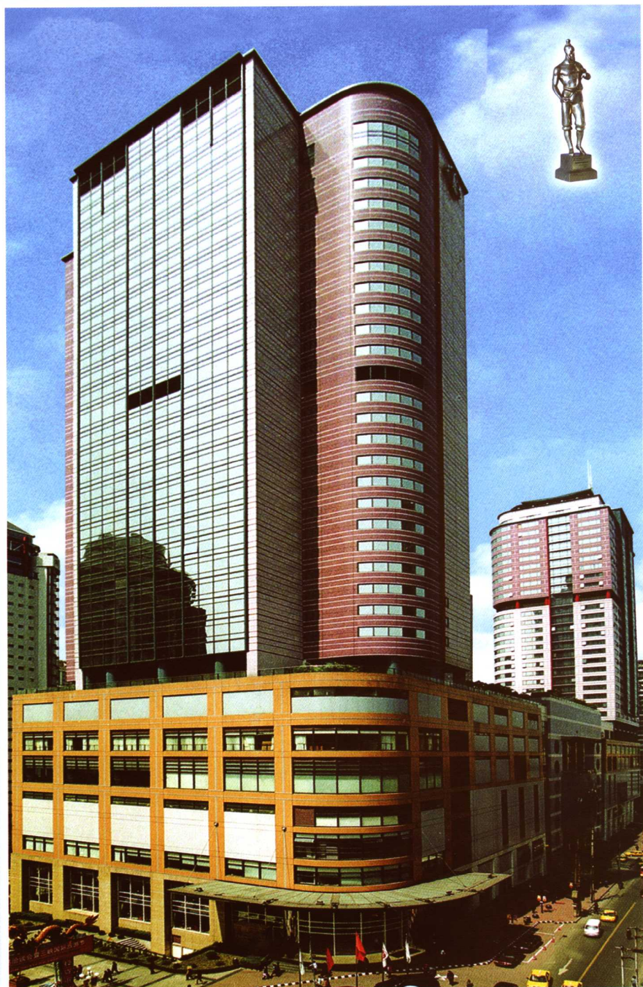
重庆大都会广场工程
