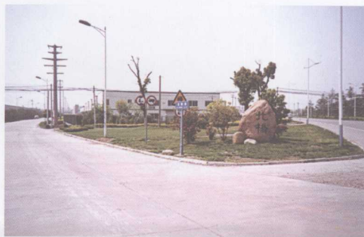
北桥镇希望工业园一角
