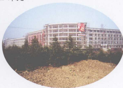
建设中的物流中心
