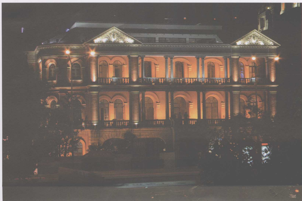
· 修缮后的上海外滩九号楼
