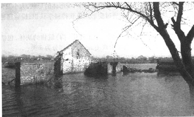
图 1-2 塌陷区村庄被水淹没
