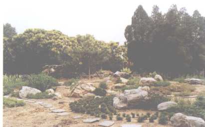
图 9-2 步石半埋土中，露出土面 5cm 左右
