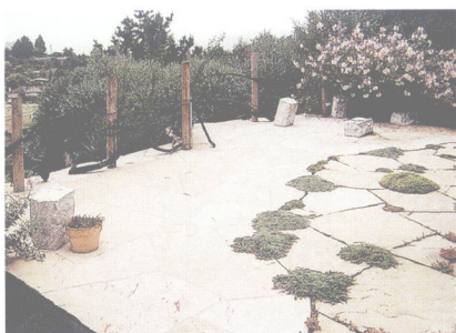
图 7-4 冰纹小广场铺设空隙种匍匐植物
