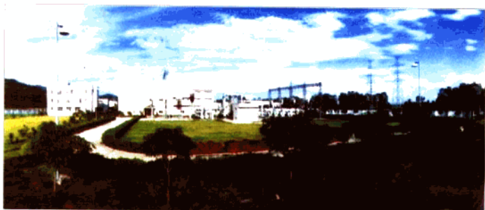
220 千伏新会变电站
