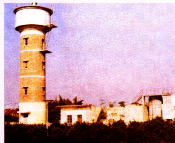
石碣镇桔洲乡水塔（1987年）。
