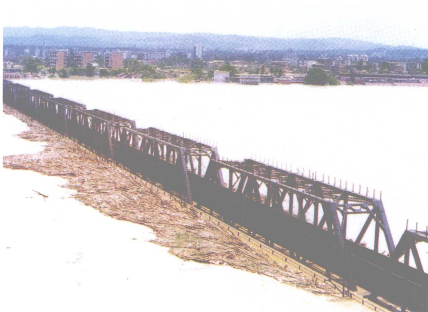
1996年7月中旬，柳江发生特大洪水，图为洪水淹没柳江铁路大桥，为了保护铁路大桥安全，铁路部门用50节车辆重压桥面
