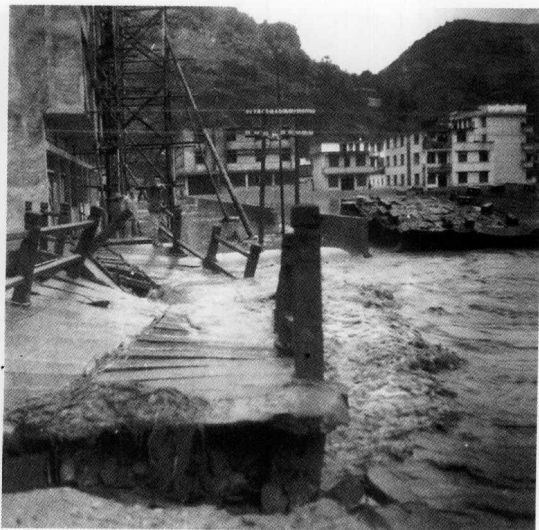
1984年10月4日，那坡县发生洪水，冲坏那坡县街头水泥桥
