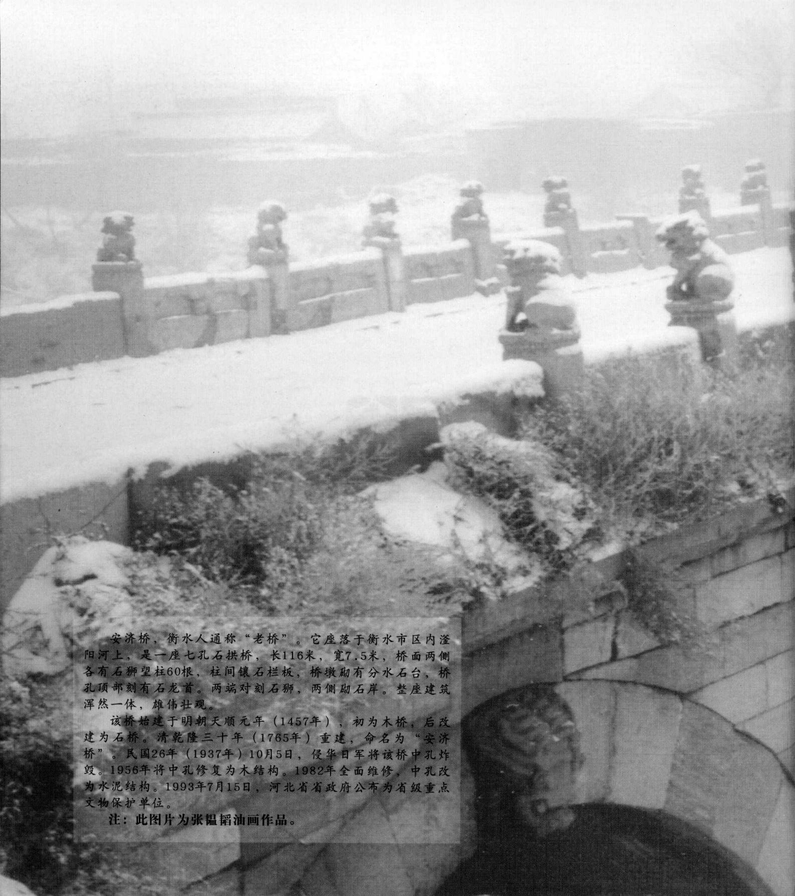
安济桥，衡水人通称“老桥”。它座落于衡水市区内滏阳河上，是一座七孔石拱桥，长116米，宽7.5米，桥面两侧各有石狮望柱60根，柱间镶石栏板，桥墩砌有分水石台，桥孔顶部刻有石龙首。两端对刻石狮，两侧砌石岸。整座建筑浑然一体，雄伟壮观。
