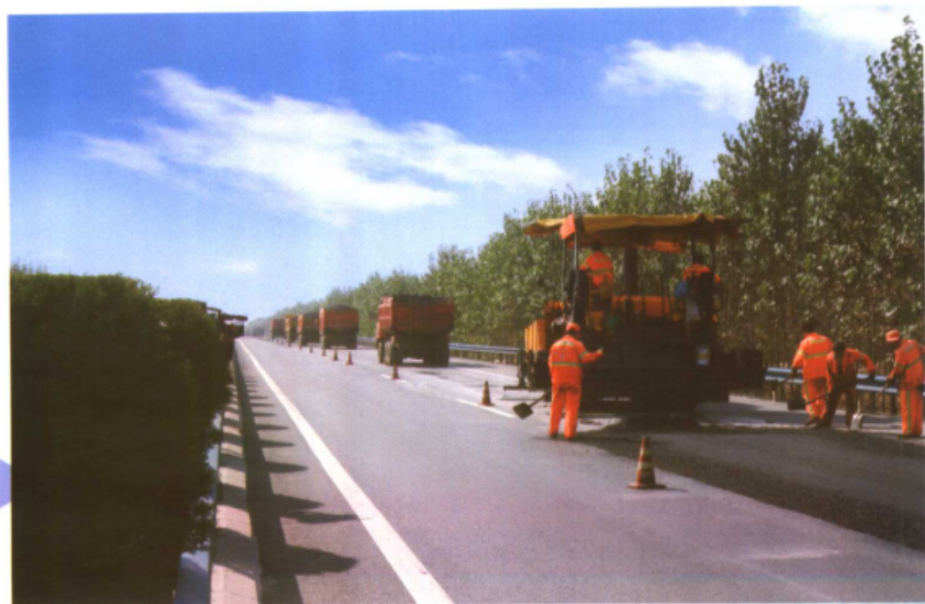
▲ 京珠高速河南段正在进行机械化养护施工
