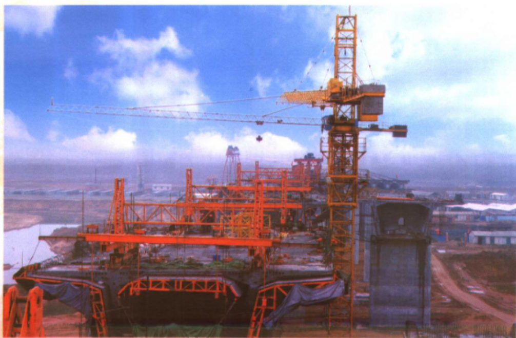
▲ 机械林立的高速公路施工工地
