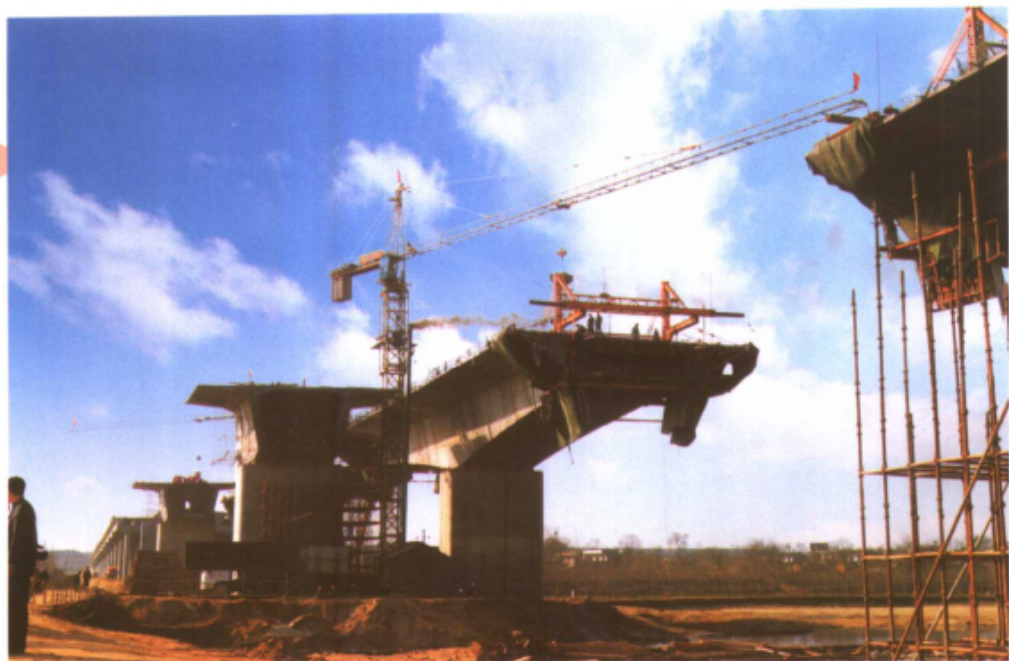
▲ 沪陕高速信南段白河特大桥施工现场
