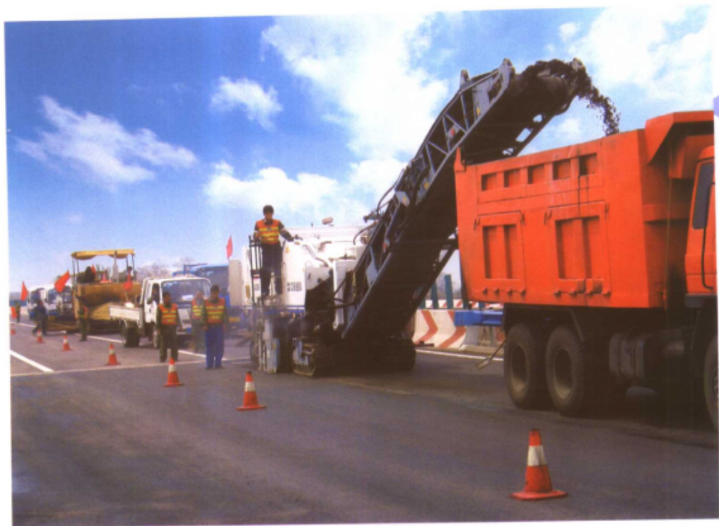
▲ 连霍高速河南段养护施工现场
